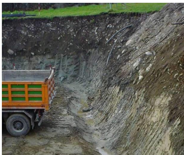
Typischer Bodenaufbau im mittleren Trassenabschnitt: oben gemischtkörniger Murschutt, unten feinkörnige Seesedimente. Assetto tipico del terreno nella parte media del tracciato: sopra detrito di debris flow a granulometria mista, sotto sedimenti lacustri fini
